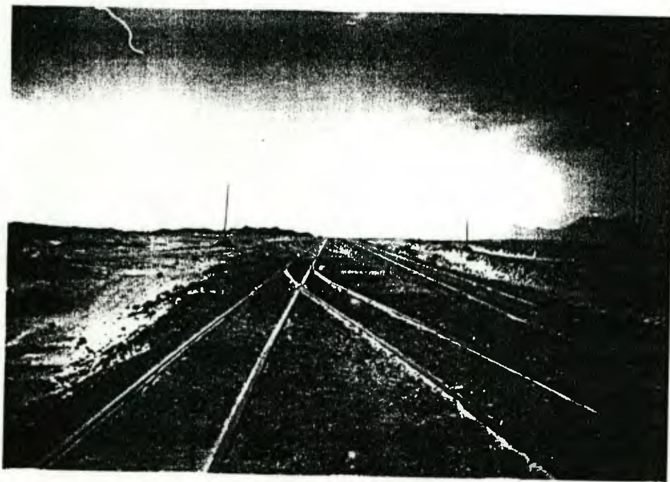
Vista panorámica del desvio.
