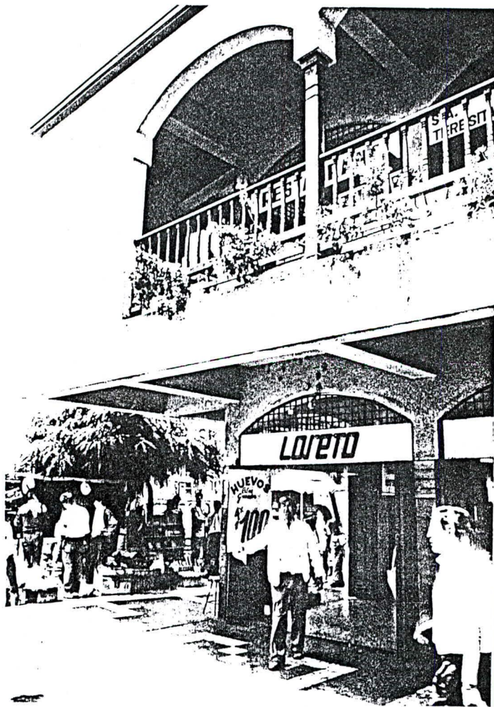
VISTA ESQUINA EXTERIOR SEGUNDO PISO.
