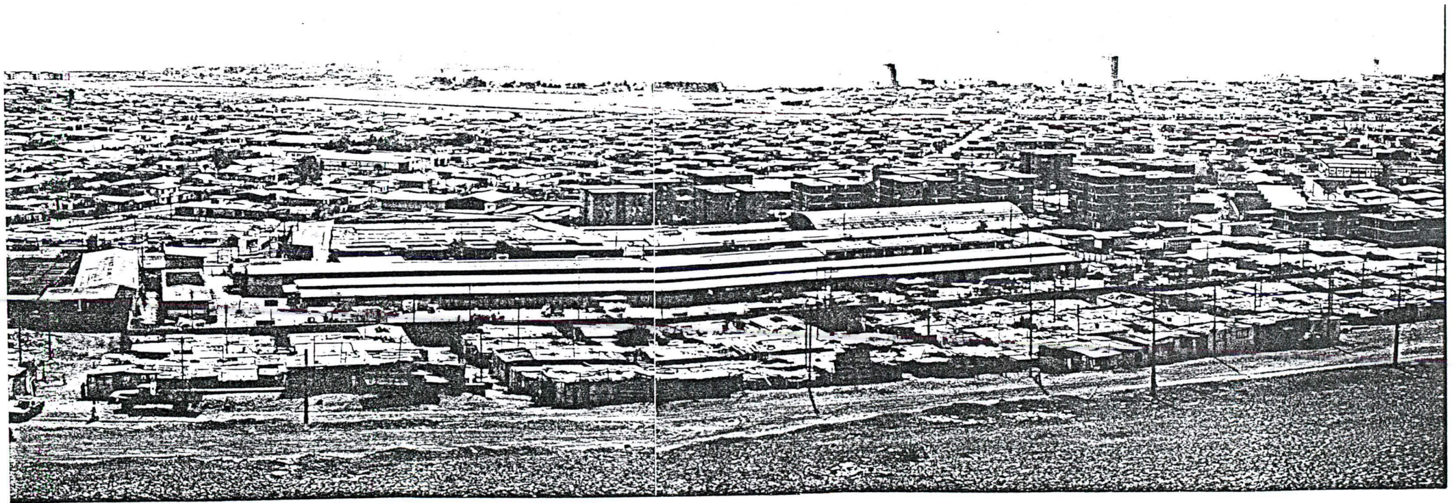
VISTA GENERAL TERMINAL AGROPECUARIO ENTRE AVDA. PROGRESO Y POBLACION CENTENARIO
